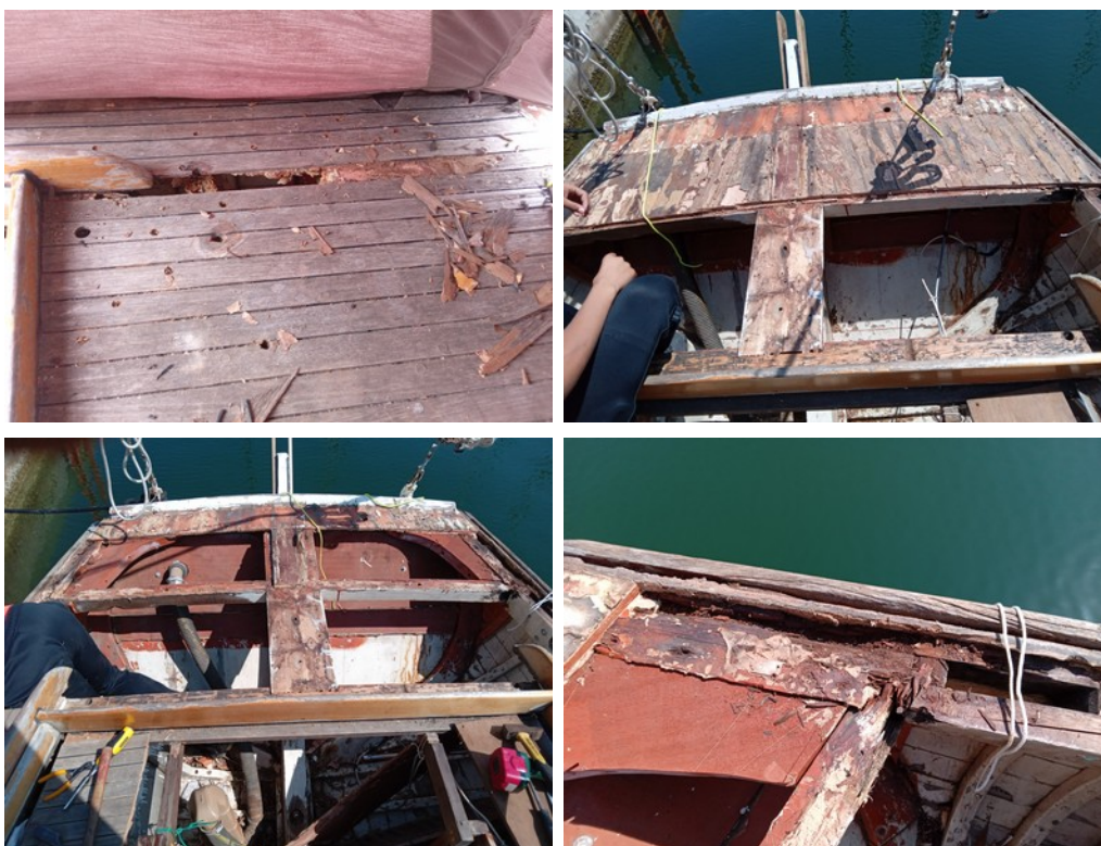
Délatage du pont arrière de Sulamith
